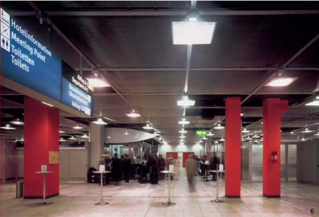
Bild 6: Dauerlicht im Flughafen- gebäude, eine typische Anwendung für Induktionslicht.
